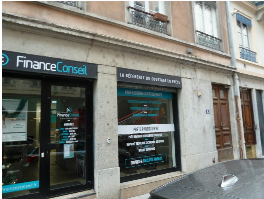
Rez-de-chaussée en structure poteau/poutre
