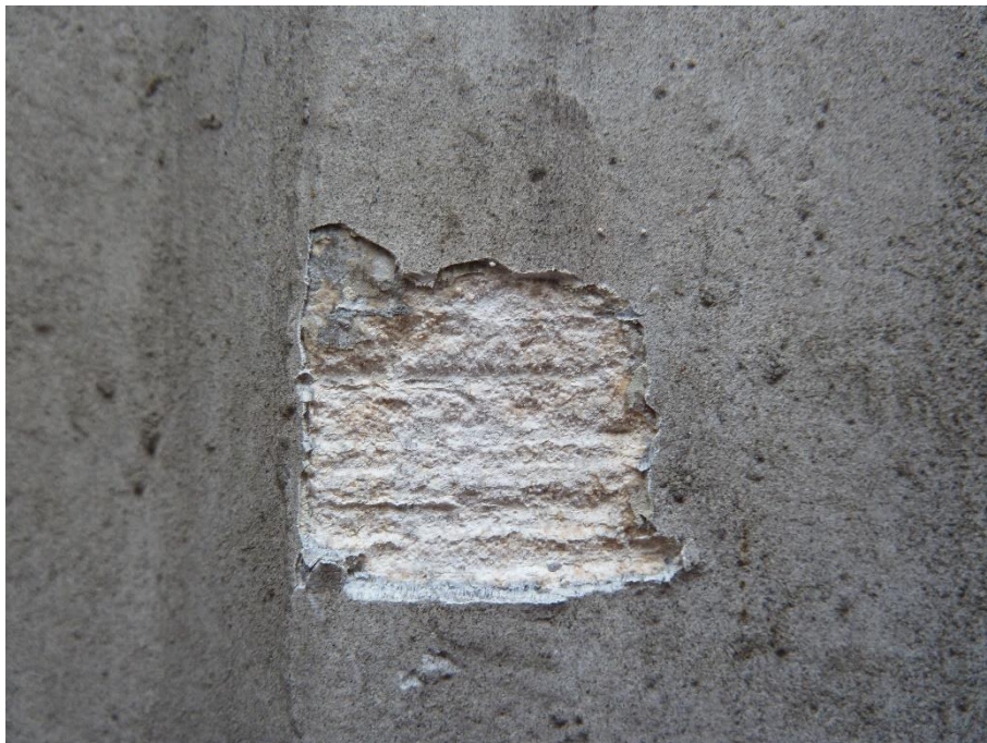
Zoom sur sondage de jambage de fenêtre : pierre du Mâconnais
