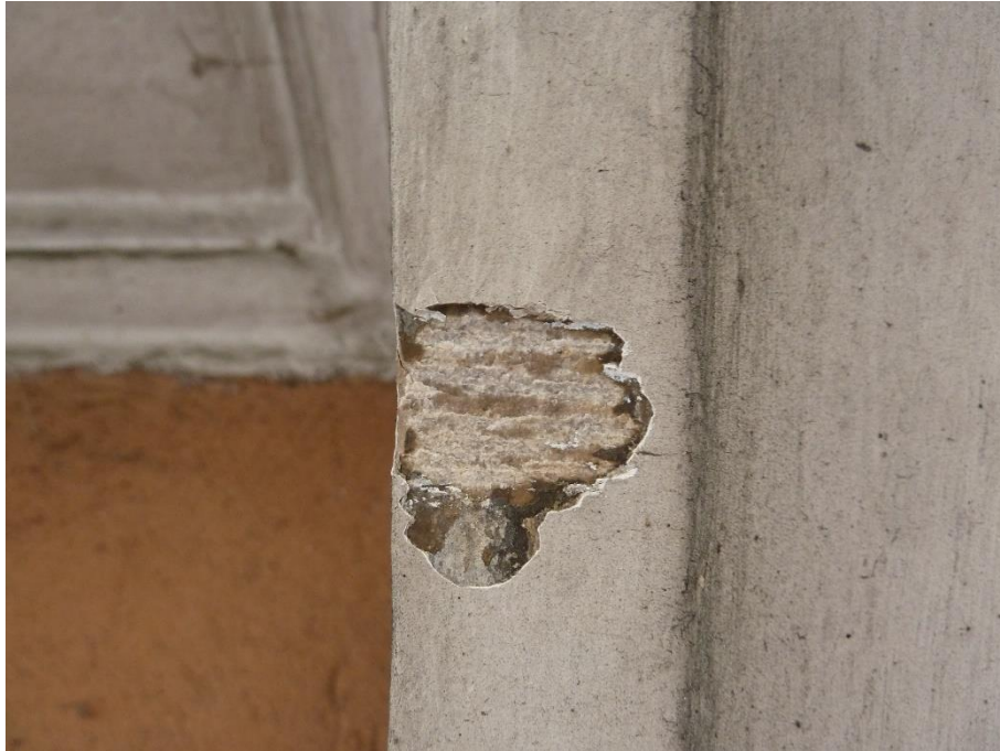
Sondage sur console de balcon : pierre de Villebois
