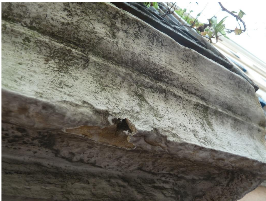
Dalle de balcon : pierre de Villebois
