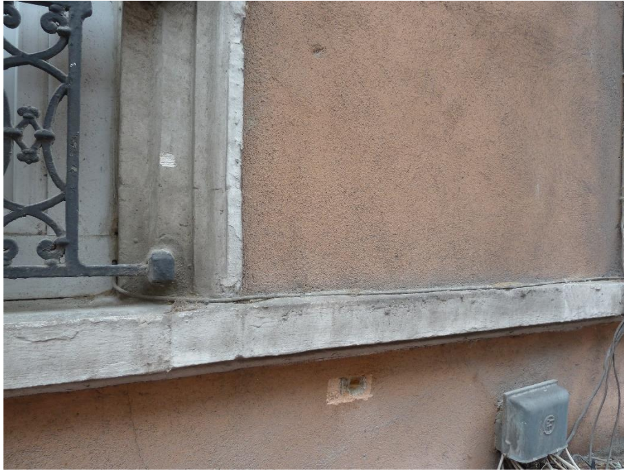
Sondage sur jambage de fenêtre
