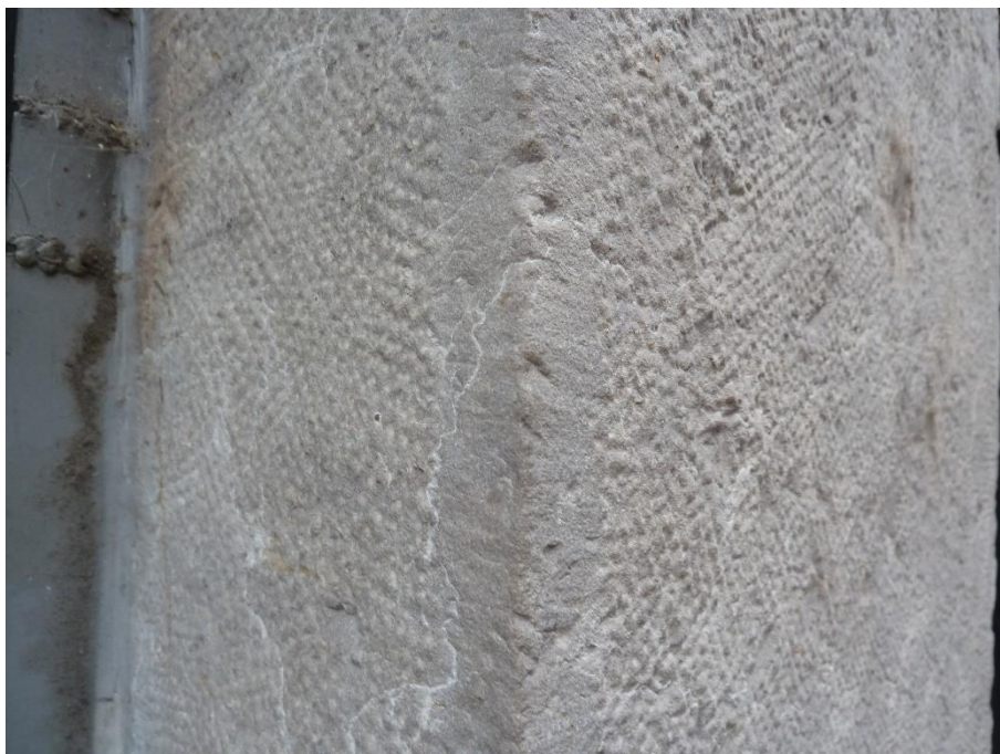
Poteau au rez-de-chaussée : pierre de Villebois
