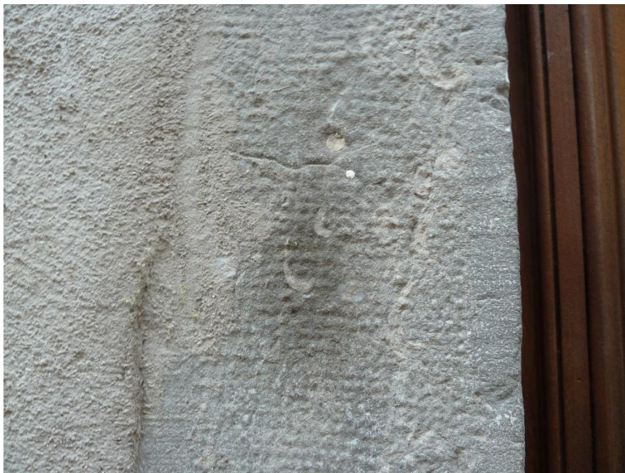
Jambage gauche de la porte d'entrée : pierre de Saint Cyr
