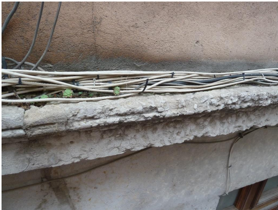
Corniche et plate-bande au rez-de-chaussée : Pierre de Villebois
