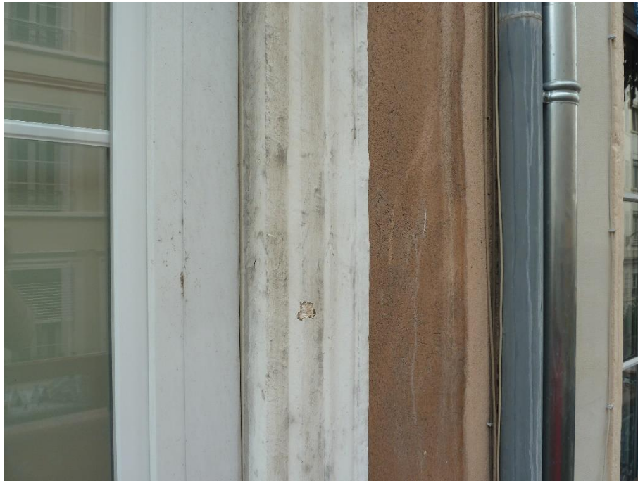
Sondage sur jambage de fenêtre
